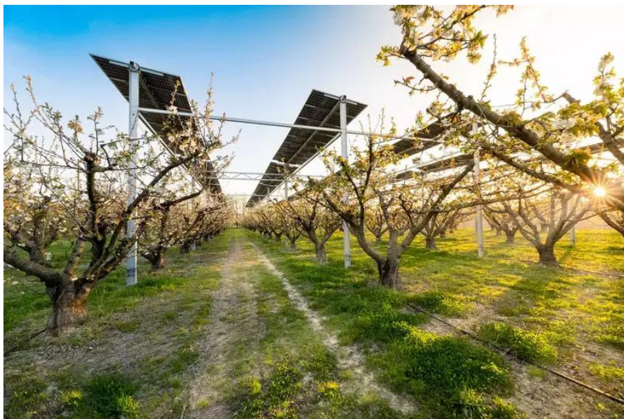
Foto 2. Sistema agrivoltaico con inseguimento monoassiale in frutteto https://sunagri.fr
