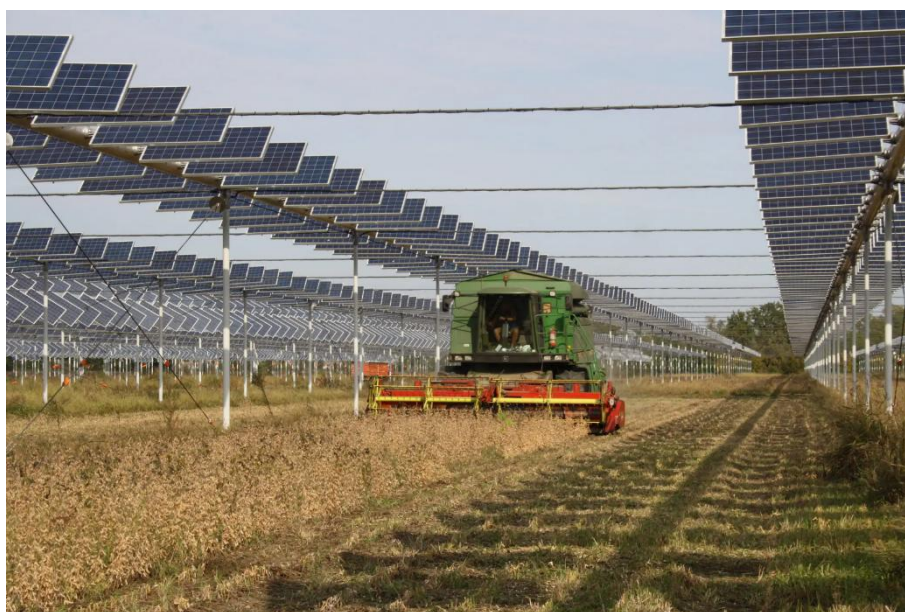
Foto 3. Sistema agrivoltaico con inseguimento solare biassiale. Fonte https://www.remtec.energy/it
