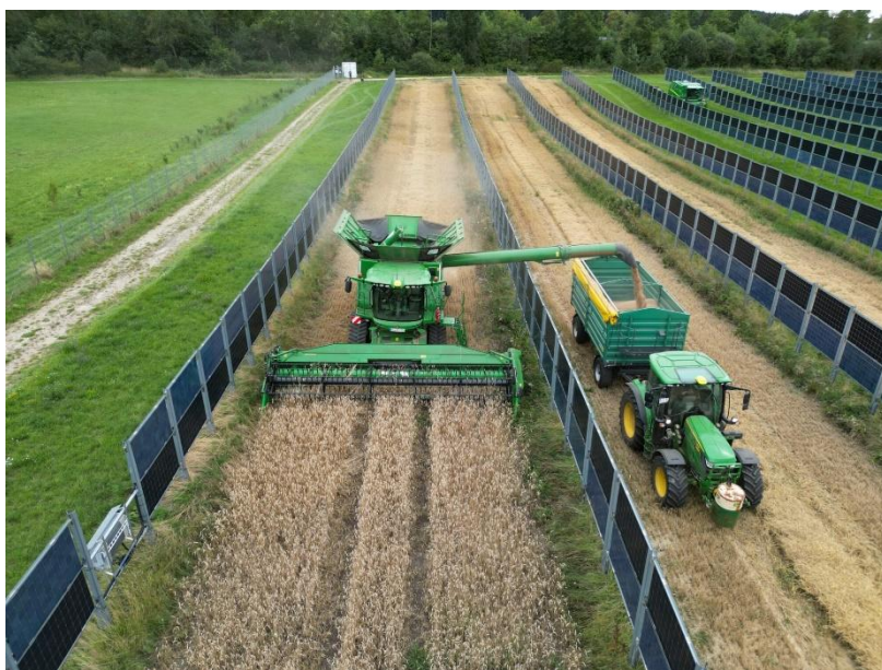
Foto 4. Sistema agrivoltaico con pannelli verticali bifacciali. Fonte https://next2sun.com/
