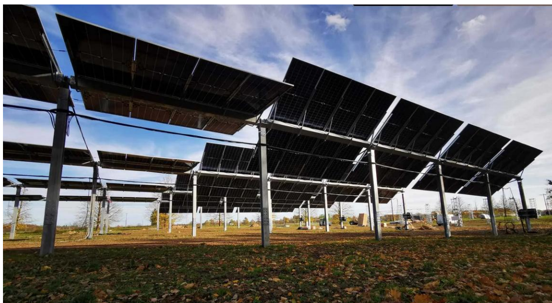
Foto 1. Sistema agrivoltaico con inseguimento solare monoassiale. Fonte https://www.remtec.energy/it
